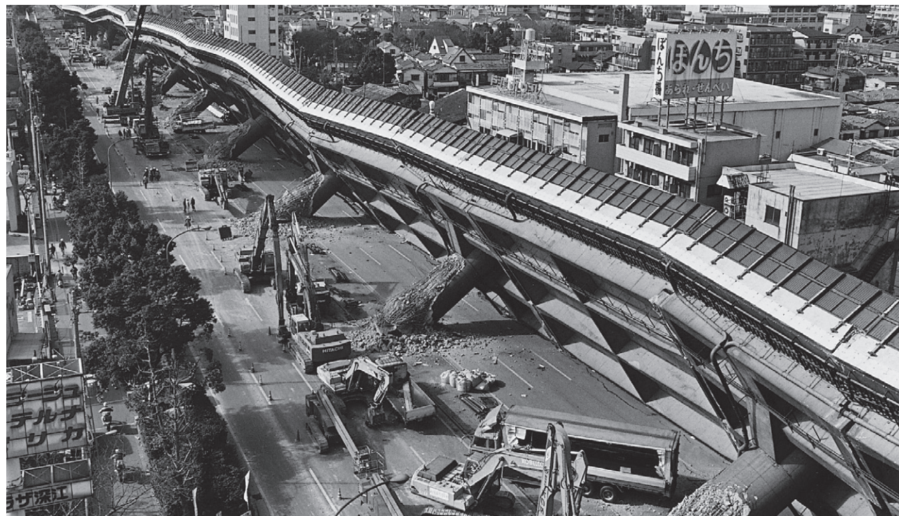
阪神・淡路大震災（1月17日）倒壊した阪神高速道路
